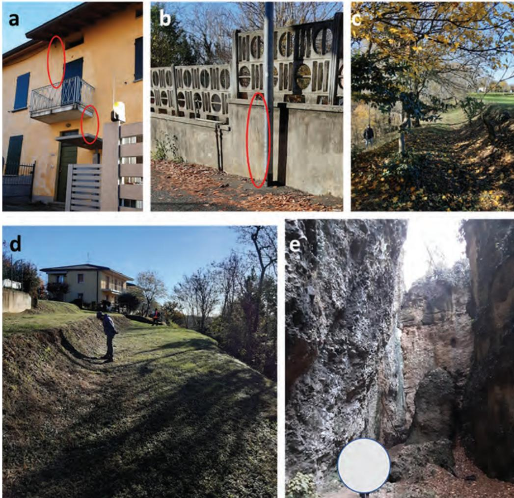
*Figura 10. a) e b) Lesioni sub-verticali su manufatti disposti lungo l'orlo del terrazzo fluvio-glaciale di Calusco; c) e d) Scarpate e terrazzi ribassati lungo l'orlo del terrazzo fluvio-glaciale di Calusco; e) Trincea principale, di  $h > 20\text{m}$  e direzione WNW-ESE, ripresa da ovest.*
